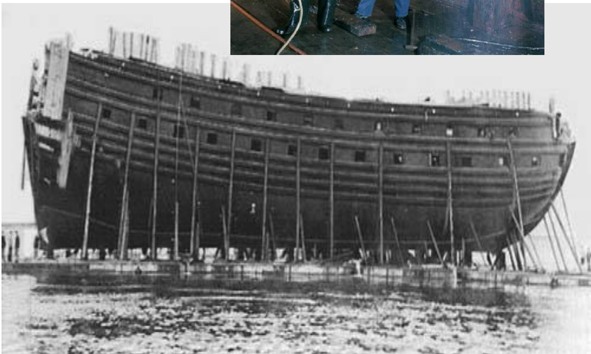
Fig. 30 y 31 Impregnación de PEG en las maderas del Vasa tras su reflote en 1961 (Foto: Museo Vasa)
