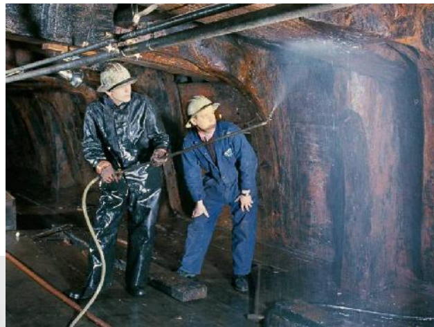
Fig. 30 y 31 Impregnación de PEG en las maderas del Vasa tras su reflote en 1961 (Foto: Museo Vasa)
