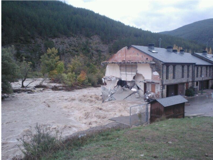
Figura 14. Unifamiliar construido en el cauce y destruido por la crecida en Octubre de 2012. Fuente: Heraldo de Aragón, 20/10/2012
