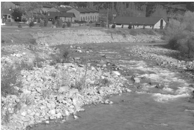
Figura 15. Margen erosionada por el río en Villanúa que afecta directamente a una urbanización cercana en Octubre de 2012. Fuente: Geographicalia
