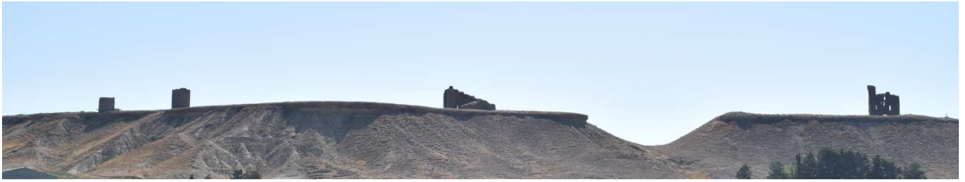
Figura 9. Vista general, El Bayo.
