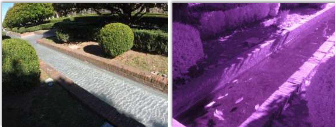
Imagen 27: Comparación imagen capturada con cámara convencional y cámara infrarroja. Fuente propia.
