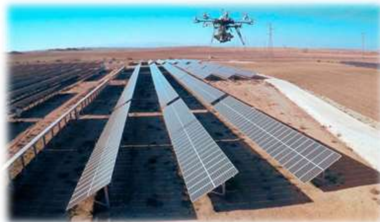
Imagen 3: Inspección termográfica placas solares. Fuente: www.youtube.com
