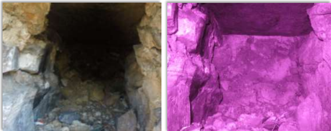
Imagen 26: Comparación imagen capturada con cámara convencional y cámara infrarroja. Fuente propia.
