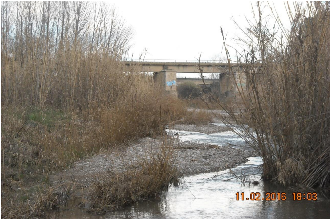
Fotografía 7. El río Sosa en la zona del puente del ferrocarril en el año 2016.
