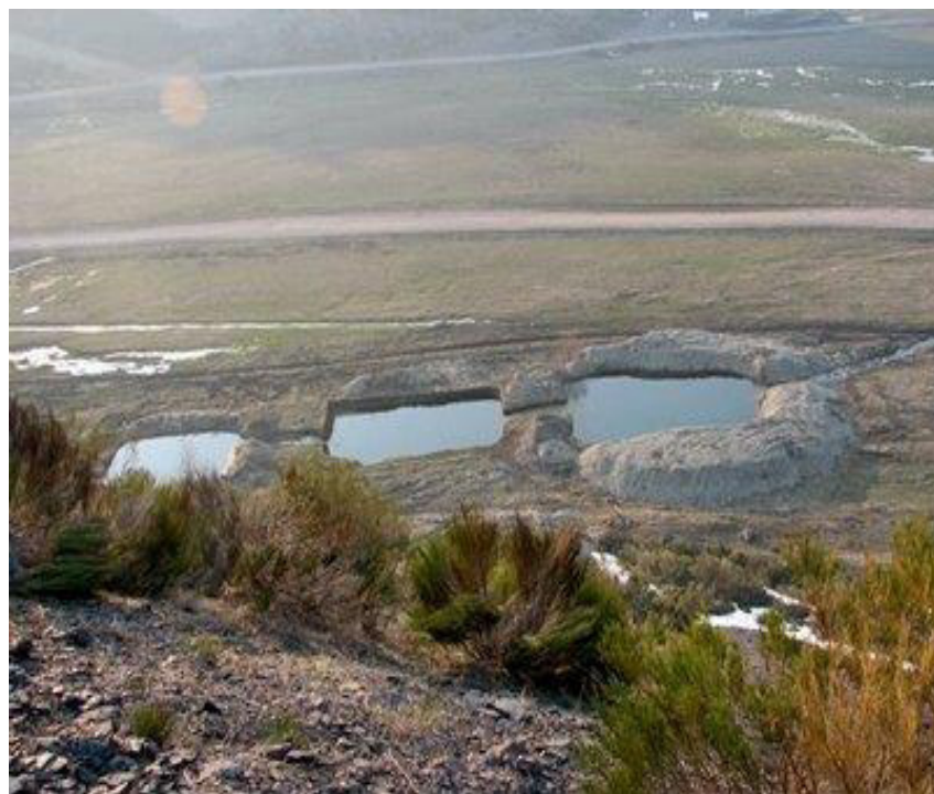
Ilustración 1: Balsas de decantación
