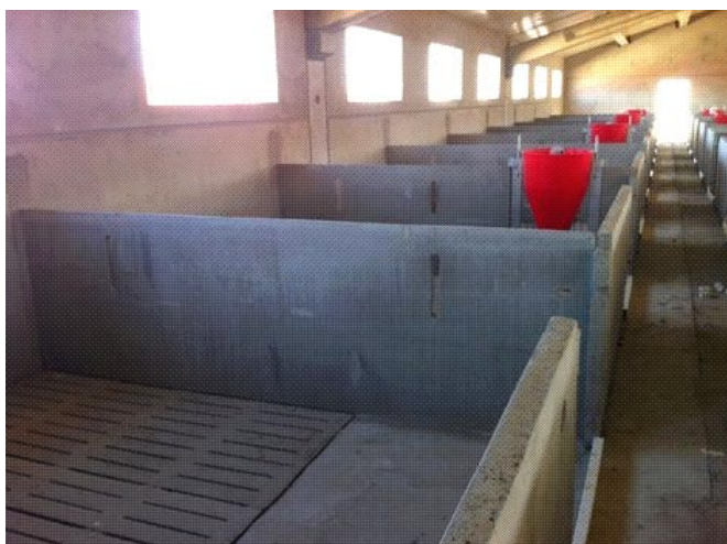
Imagen 10. Ejemplo del tipo de cebadero escogido con estructura prefabricada y cerramiento de obra.
