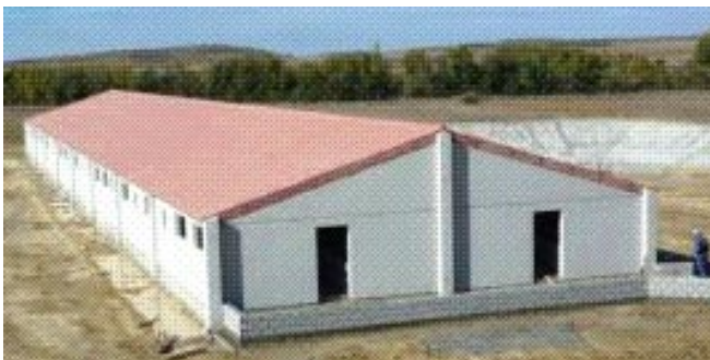
Imagen 17. Ejemplo de cebadero con sistema de ventilación estática horizontal.
