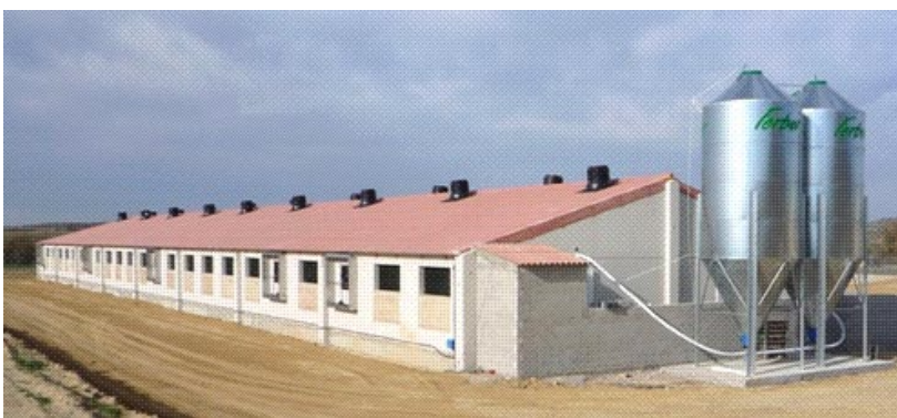
Imagen 19. Ejemplo de cebadero con sistema de ventilación dinámica por extracción mediante ventiladores en chimeneas.
