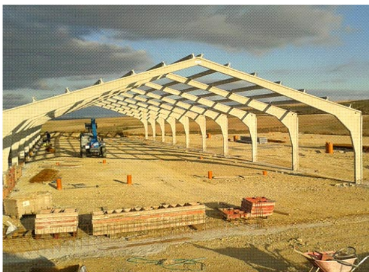
Imagen 8. Ejemplo de estructura prefabricada de hormigón armado.
