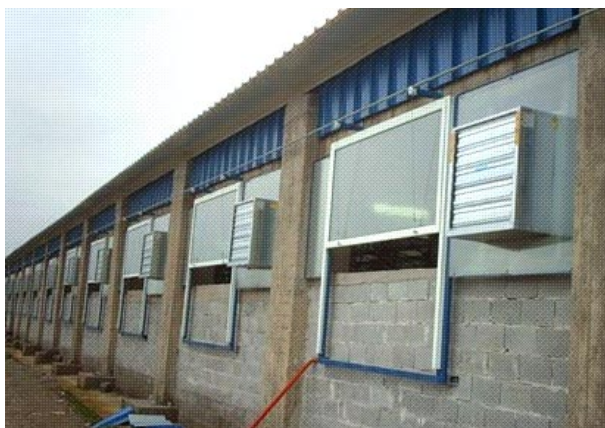
Imagen 20. Ejemplo de cebadero con sistema de ventilación dinámica por inyección mediante ventiladores en las fachadas laterales.
