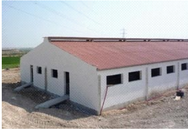
Imagen 21. Ejemplo de sistema de ventilación estática vertical.
