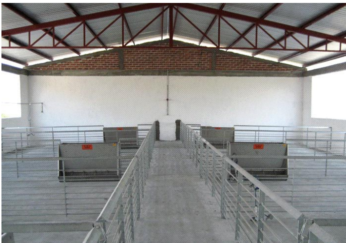
Imagen 9. Ejemplo de estructura metálica.
