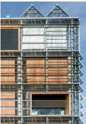
F81. Materialidad: madera y policarbonato.
