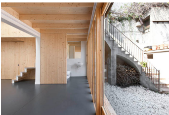
F57. Paneles de madera en el interior.
