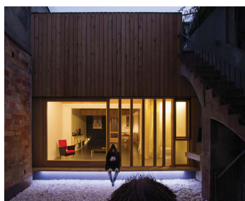
F50. Edificio tras la rehabilitación. Demanda energética: 17 kWh/m 2 año.
