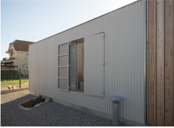
F45. Envoltente con cerramiento de panel de chapa y tableros de madera prefabricados.
