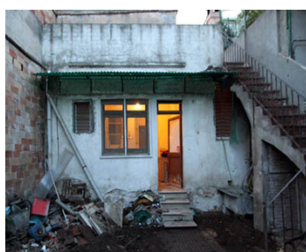
F49. Situación previa del edificio. Demanda energética: 171 kWh/m 2 año.
