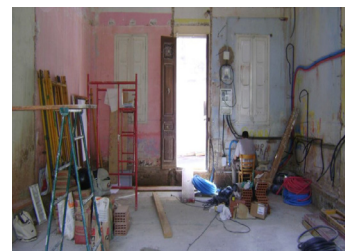
F52. Situación previa del interior del edificio.
