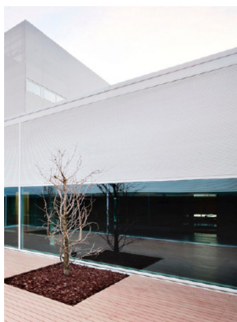
F67. F68. Uso de la chapa de acero en el interior y en el exterior con distintos acabados.
