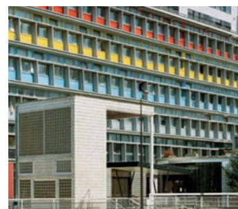
F16. Fachada sur. 1933.
