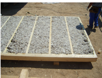
F47. Panel prefabricado de madera con estructura interna y aislamiento de lana de oveja.
