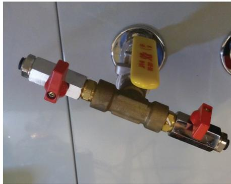
Figura 4 – Toma de aire comprimido.
