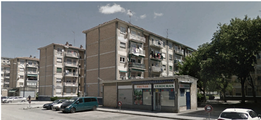
Fig. 23 Vista de Balsas de Ebro Viejo - Fuente: Google Earth
