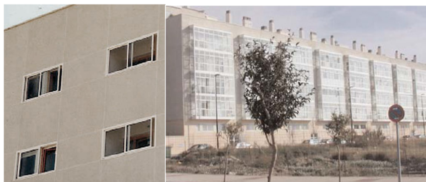
Fig. 13 Abertura de huecos en fachada norte frente a fachada sur - Fuente: La Experiencia en Parque Goya
