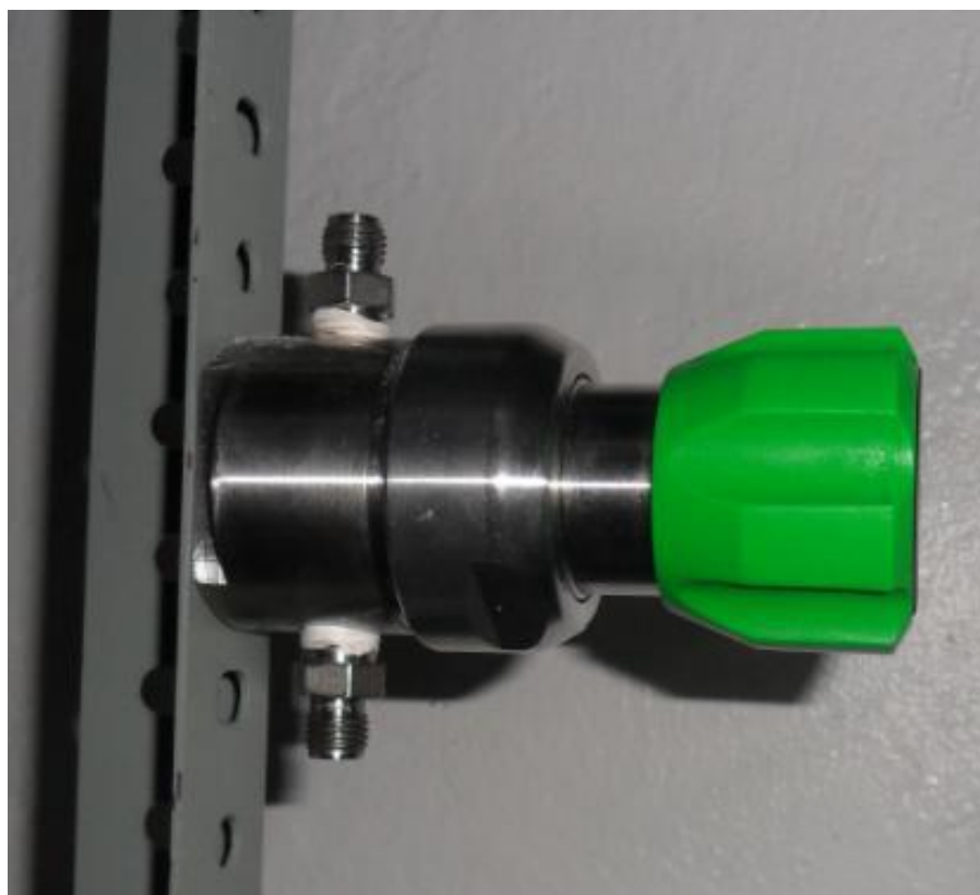
Figura I.6 Válvula reguladora de presión
