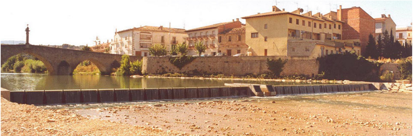
Imagen del azud de Valderrobres en fase de ejecución, donde se aprecian las dos palas abatibles de 25m que elevan en nivel del agua 1,20m. Foto: EINAR S.A., 2003.
