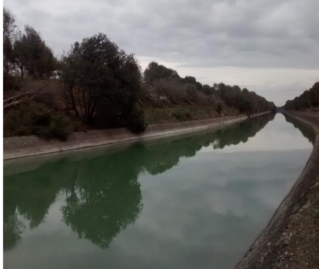
Figura 6. Fotografía del Canal de Bárdenas y la zona del aprovechamiento forestal. (Archivo propio)
