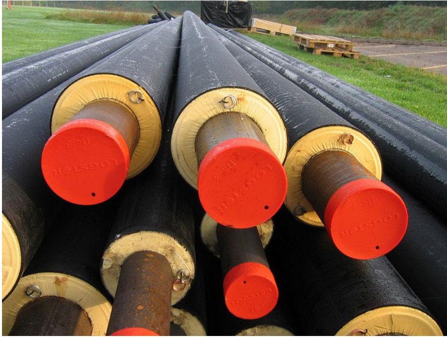
Figura 2. Tubos de calefacción urbana. [5]
