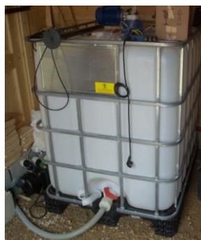
**Neutralización : depósito equipado con un agitador y una bomba para la dosificación de HCl**
