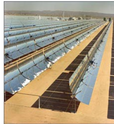
Figura 6 Concentrador de energía solar
