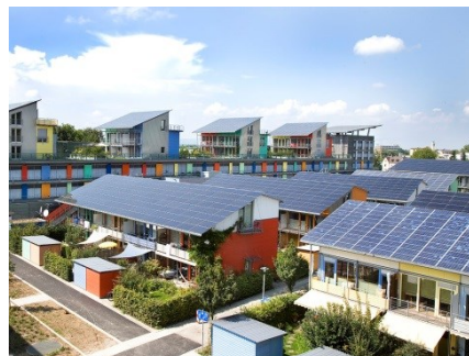
Figura 8 Instalación fotovoltaica instalada en el techo
