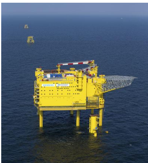
Ilustración 5: Foto de un centro de transformación offshore. Fuente: Siemens
