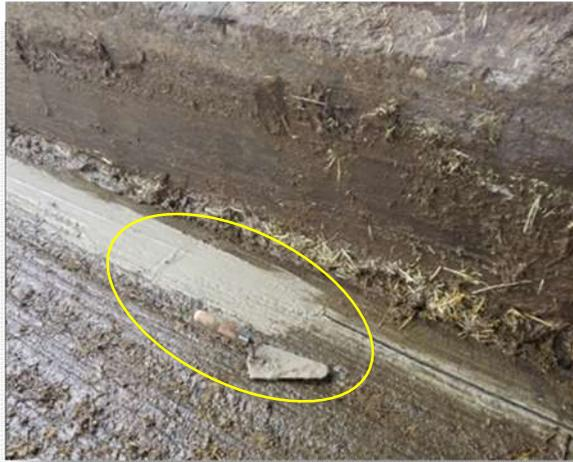
4. Una vez el cemento se secó, se fijó un extremo del cable al hierro de la cornadiza (Figura 13).
