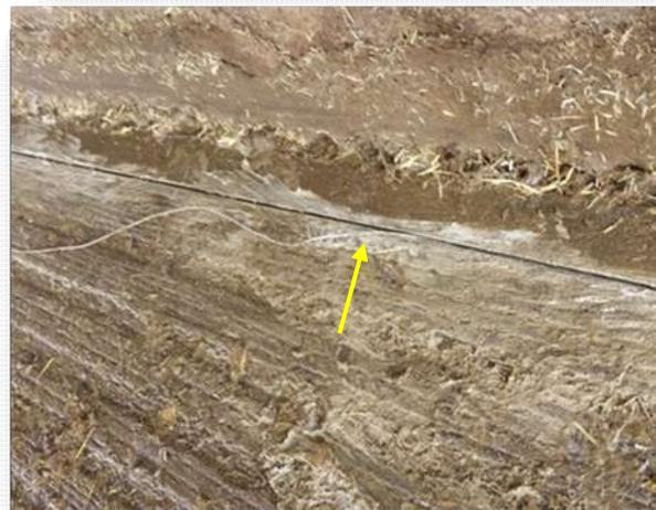
3. Se tapó el cable en la ranura con cemento rápido después asegurarse que estuviera bien metido, sujeto y sin roturas en la continuidad (Figura 12).
