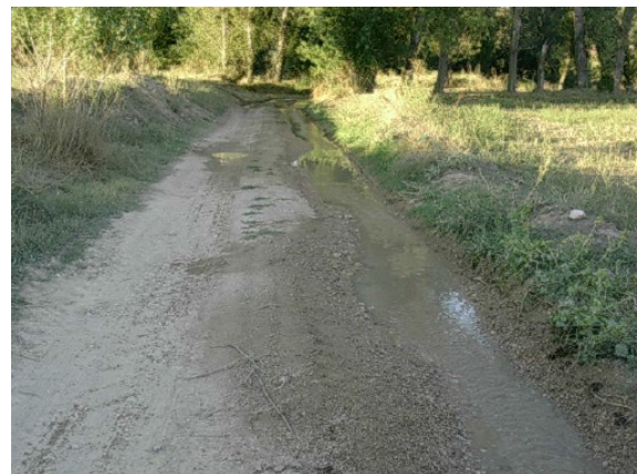
Ilustración 8: Aparición de aguas residuales en el camino
