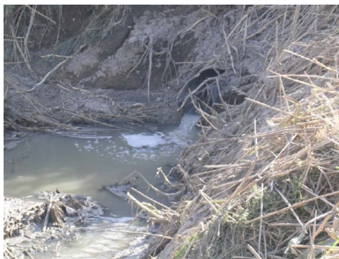
Ilustración 3: Punto de vertido actual
