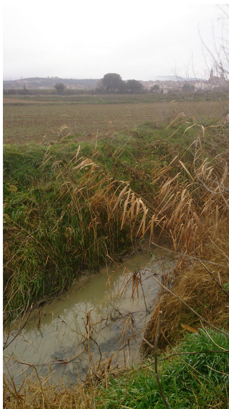
Ilustración 5: Detalle de la zanja de vertido actual
