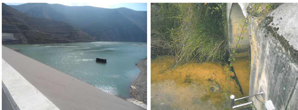
Figura 5.5. Desagüe de fondo
