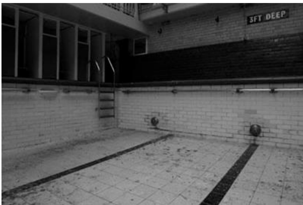
96. Sistema de recirculación, Reddish Swimming Baths 1905
