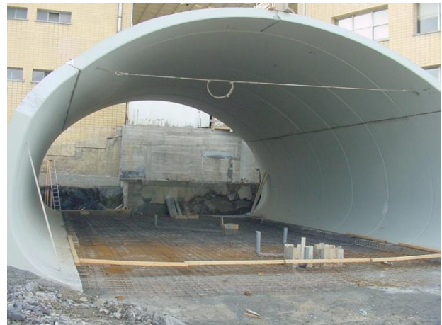
143. Armado para losa de bóveda secundaria
