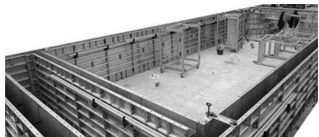
40. Disposición de encofrados para vaso de piscina
