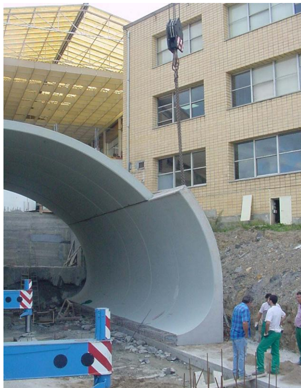
141. Proceso constructivo del elemento estructural
