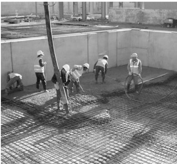
32. Ejecución de solera con paneles de hormigón ya colocados
