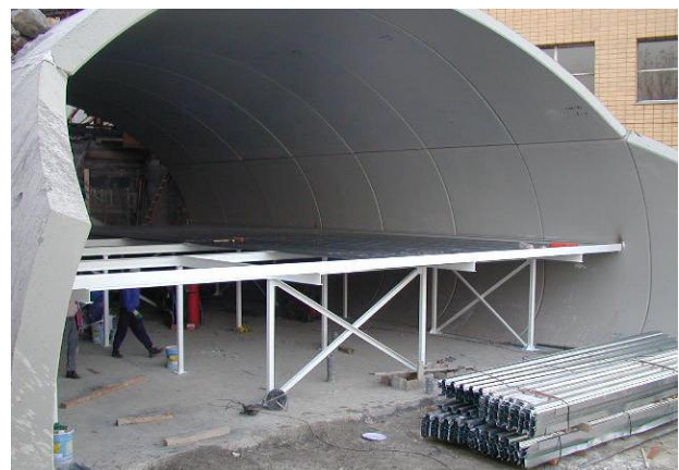
144. Estructura metálica para forjado intermedio sobre losa
