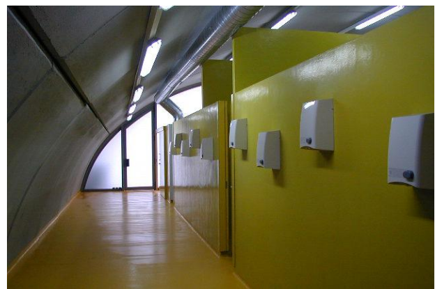
147. Iluminación y ventilación en bóveda secundaria
