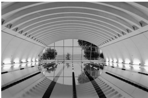
137. Piscina Colegio Vizcaya en Zamudio, ACXT
