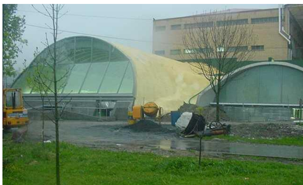
145. Impermeabilización y aislamiento de las bóvedas
