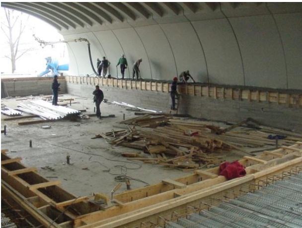
142. Proceso constructivo del vaso de la piscina
