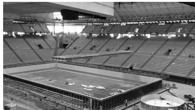
34. Piscina de paneles metálicos en el Palau Sant Jordi
