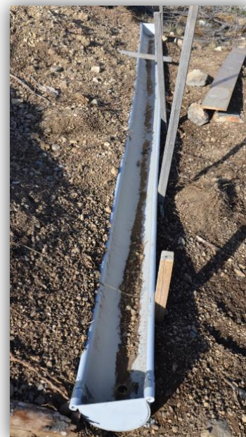
Fotografía 35. Canaleta instalada en la trocha 2.
