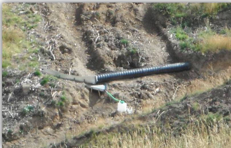
Fotografía 19. Canaleta trocha 1 y boca de rana.
