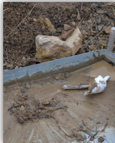
Fotografía 28. Sedimento atrapado en la boca de rana (febrero 2014).
