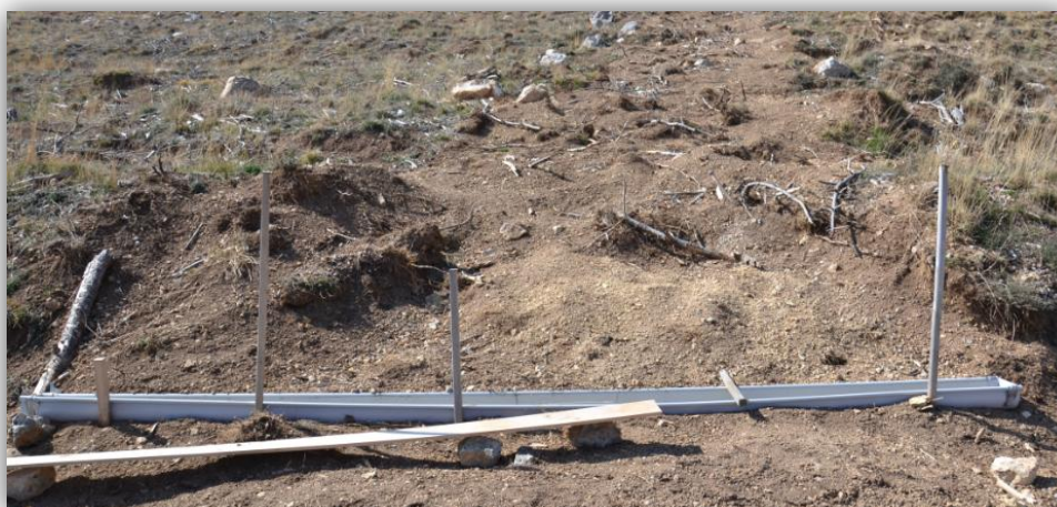
Fotografía 14. Canaleta instalada en la trocha 2.
