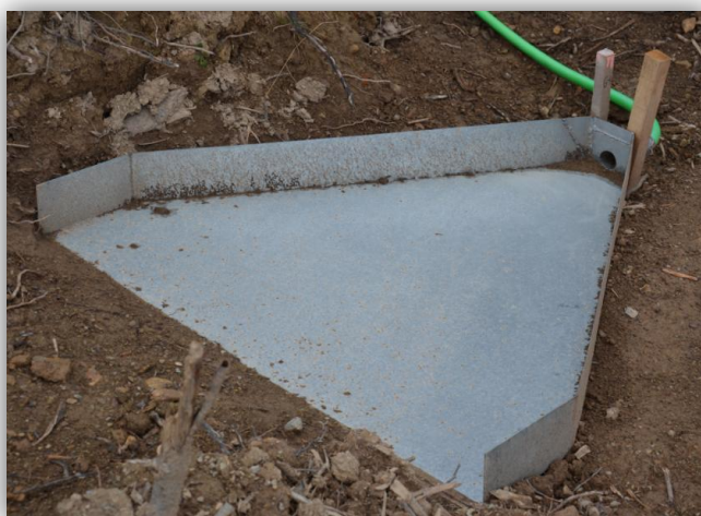
Fotografía 20. Respuesta de la boca de rana al primer evento de precipitación.
