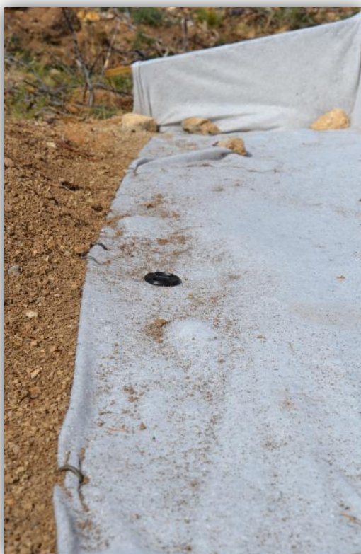
Fotografía 11. Geotextil en la trocha 2.
