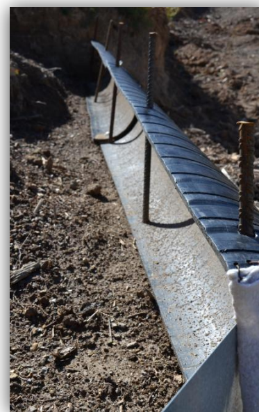
Fotografía 13. Detalle de canaleta en la trocha 1.
