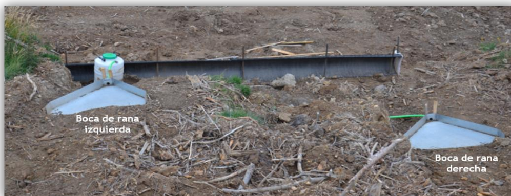
Fotografía 15. Bocas de rana instaladas en la trocha 1.
