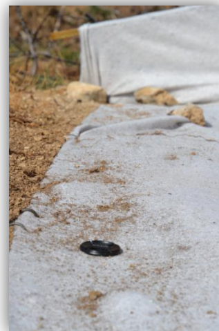
Fotografía 33. Detalle del sedimento atrapado sobre el geotextil.
