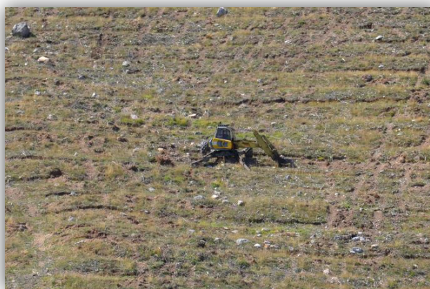
Fotografía 39. Maquinaria pesada en la ladera.
