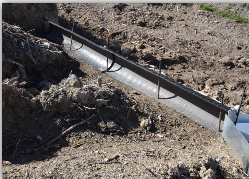
Fotografía 12. Canaleta instalada en la trocha 1.
