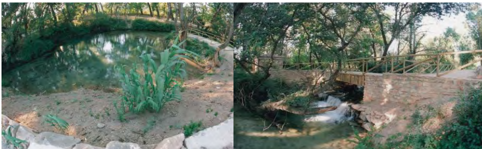
Infraestructuras en el nacimiento del Río Cubillas
