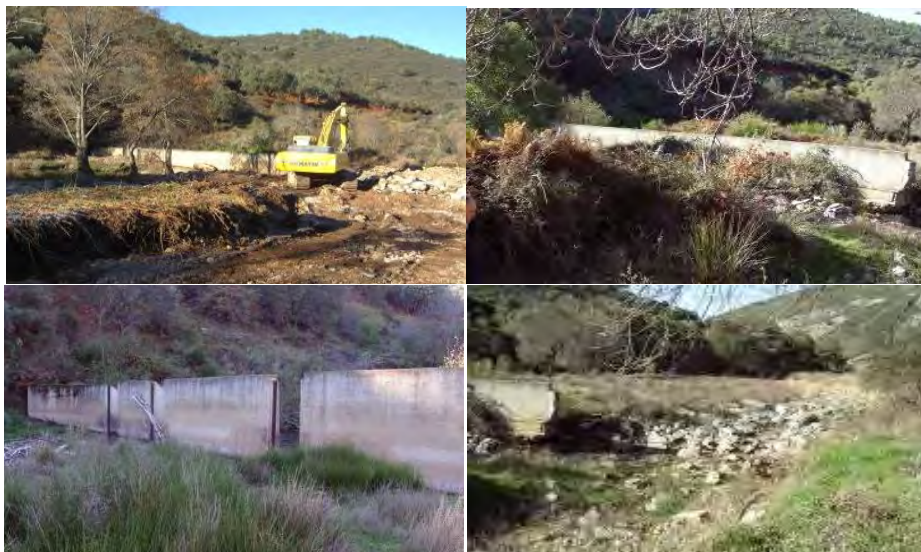
Imágenes del azud y su demolición
