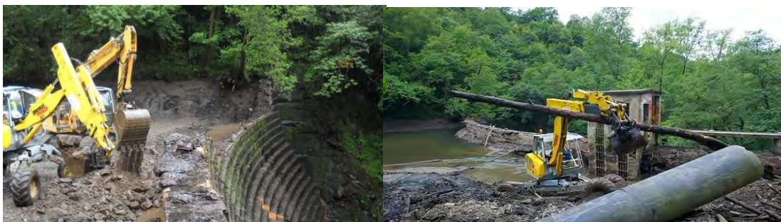
Demolición de la presa y eliminación de vegetación del cauce
