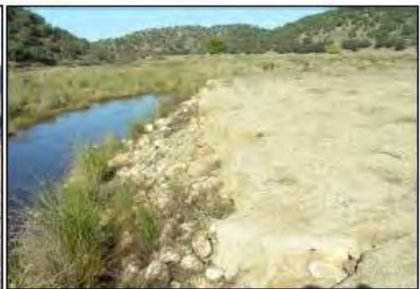
Estado previo a las actuaciones
