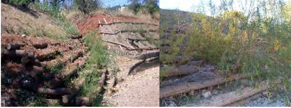
Restauración de márgenes en el Puente de Tör
