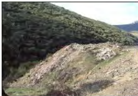
Vertedero sobre el talud de la carretera
