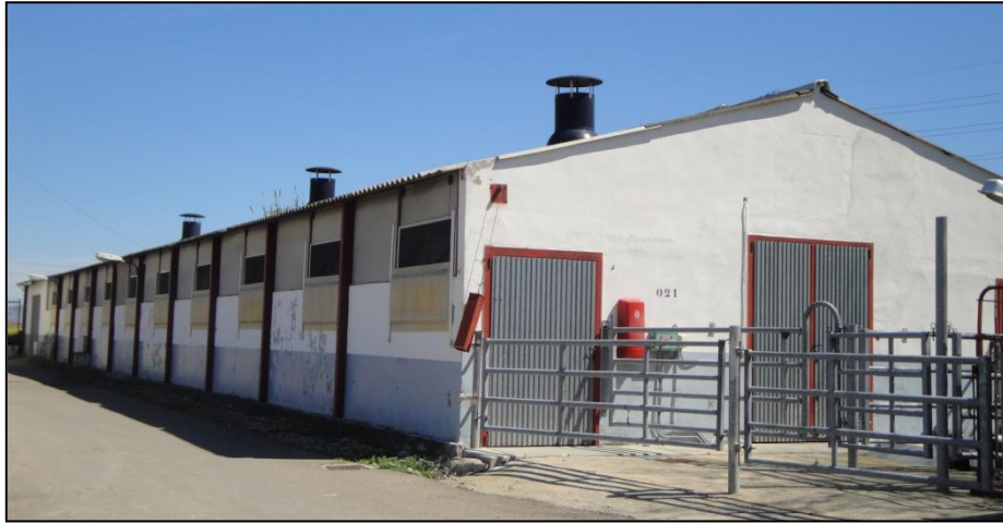
Foto 2: Nave de terneros, vista exterior.
