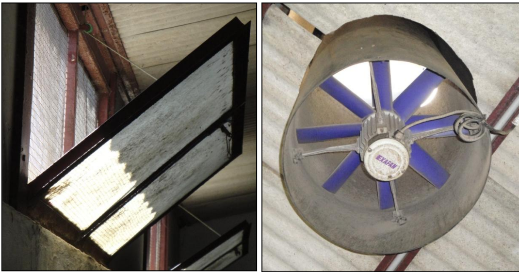
Foto 4: Detalle de una ventana y un extractor de aire.
