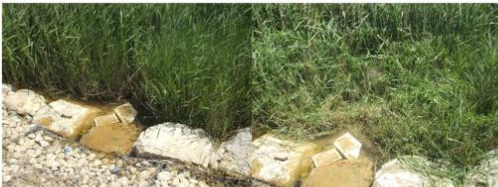
Imagen 2. Adecuación del punto de muestreo de entrada.
