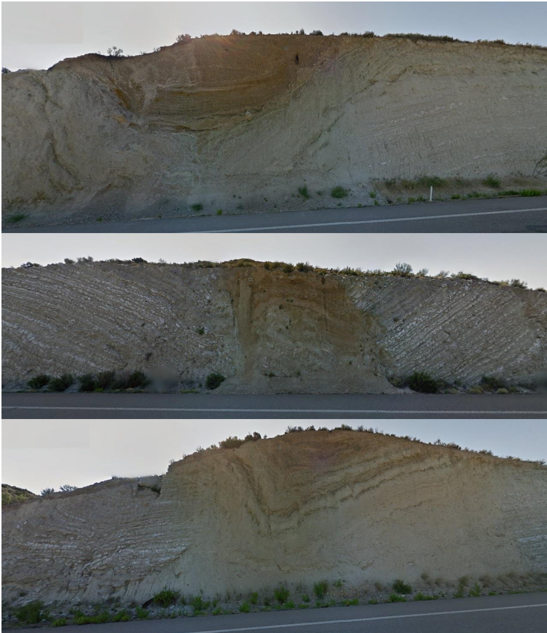
Fig. 8.- Paleodolinas observadas en el talud de la carretera A-222, en las cercanías de la zona de estudio.
