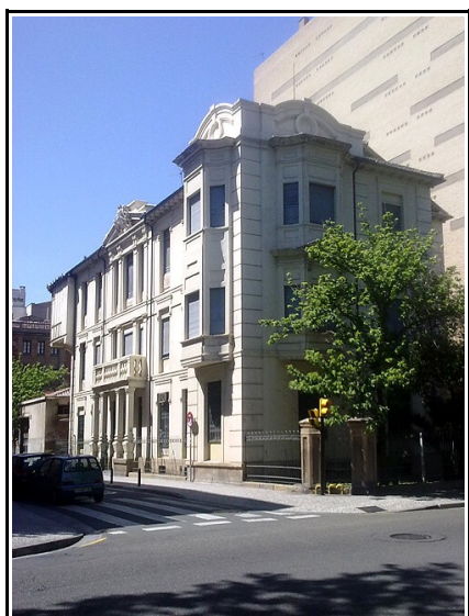
Fig.24.– Vista exterior desde el ángulo opuesto, del solar ocupado por la construcción de Félix Navarro.
