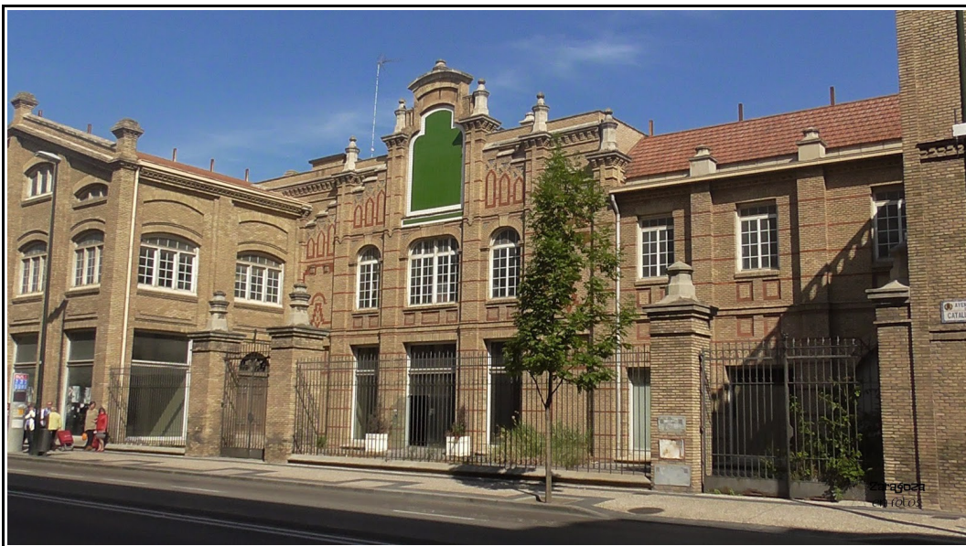
Fig.33.– Exterior fábrica de galletas Patria.
