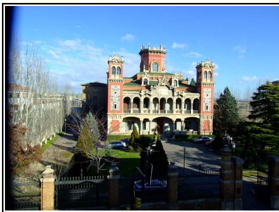
Fig.20.– Vista actual del Palacio Larrinaga.
