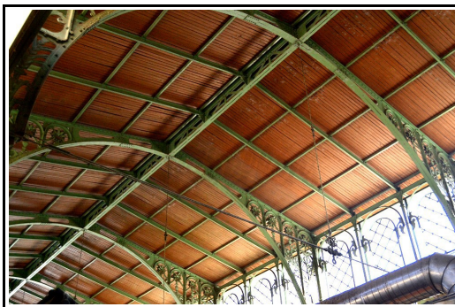
Fig.14.– Interior Mercado Central, detalle cercha
