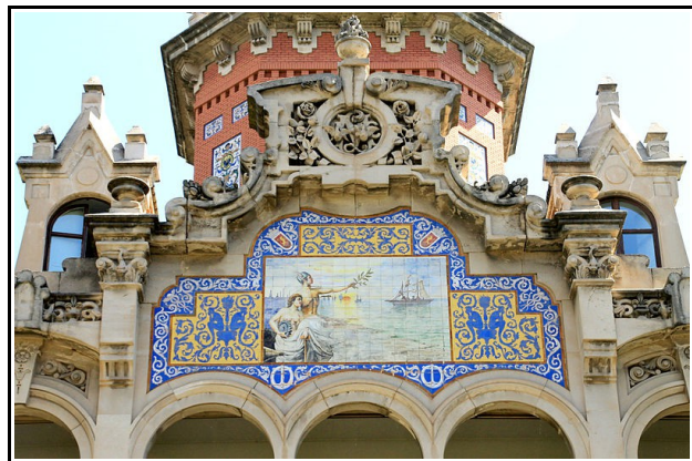
Fig.23.– Panel de azulejos polícromos de la fachada principal. Foto: A. Ruiz.
