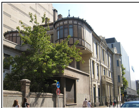
Fig.25.– Vista exterior de la parte posterior del edificio. Foto: A. Ruiz.
