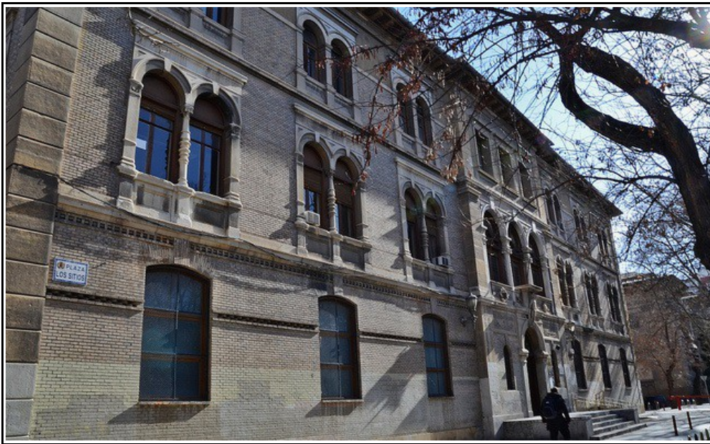
Fig.32.– Vista exterior actual del edificio.
