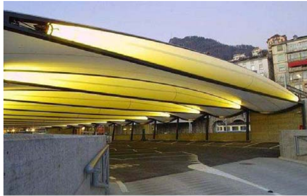
Figura 7: Garaje en Montreux, construido en 2004, las vigas son de aproximadamente 27 metros, el cable inferior se ha sustituido por un elemento rígido y se hay instalado luces en el interior.
