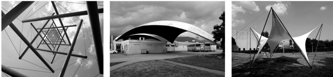
Figura 1: Izquierda: Estructura tensegrity, centro: estructura de cáscara a compresión (placa delgada sin rigidez a flexión), derecha: estructura de membrana. [1]
