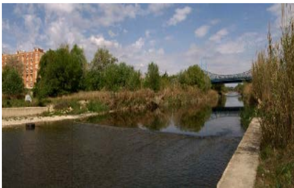
Figura 10: Estación de aforo del Gállego en Zaragoza.
