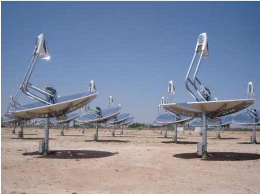
Figura 19 Sistema disco-Stirling Infinia [28].
