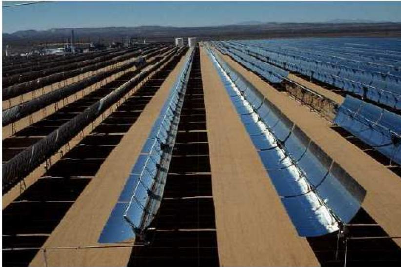
Figura 4 Imagen de la instalación de colectores cilindro-parabólicos SEGS I en California [8].
