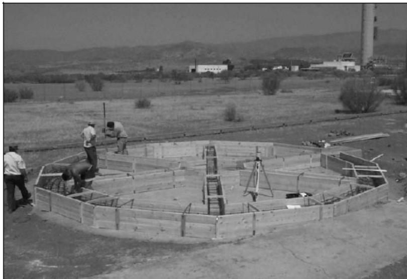
Figura 18 Imagen de la estructura de forjado del hormigón [25].
