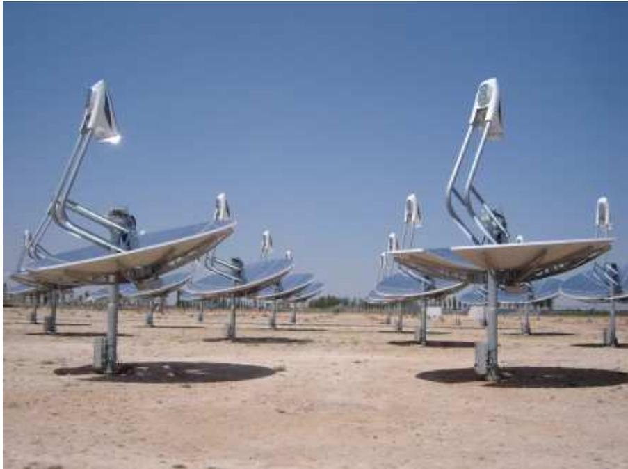
Figura 9 Sistema de disco Stirling – Infinia [25].
