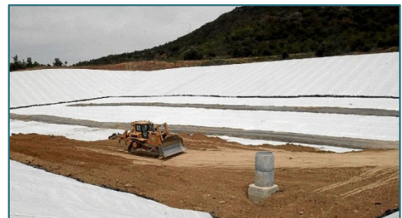
Figura 5. Nuevo vaso construido para albergar los residuos organoclorados del antiguo vertedero de Bailín. Fotografía de Jesús Fernández.
