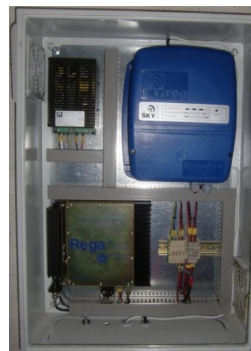
Figura 5: Unidad concentradora
