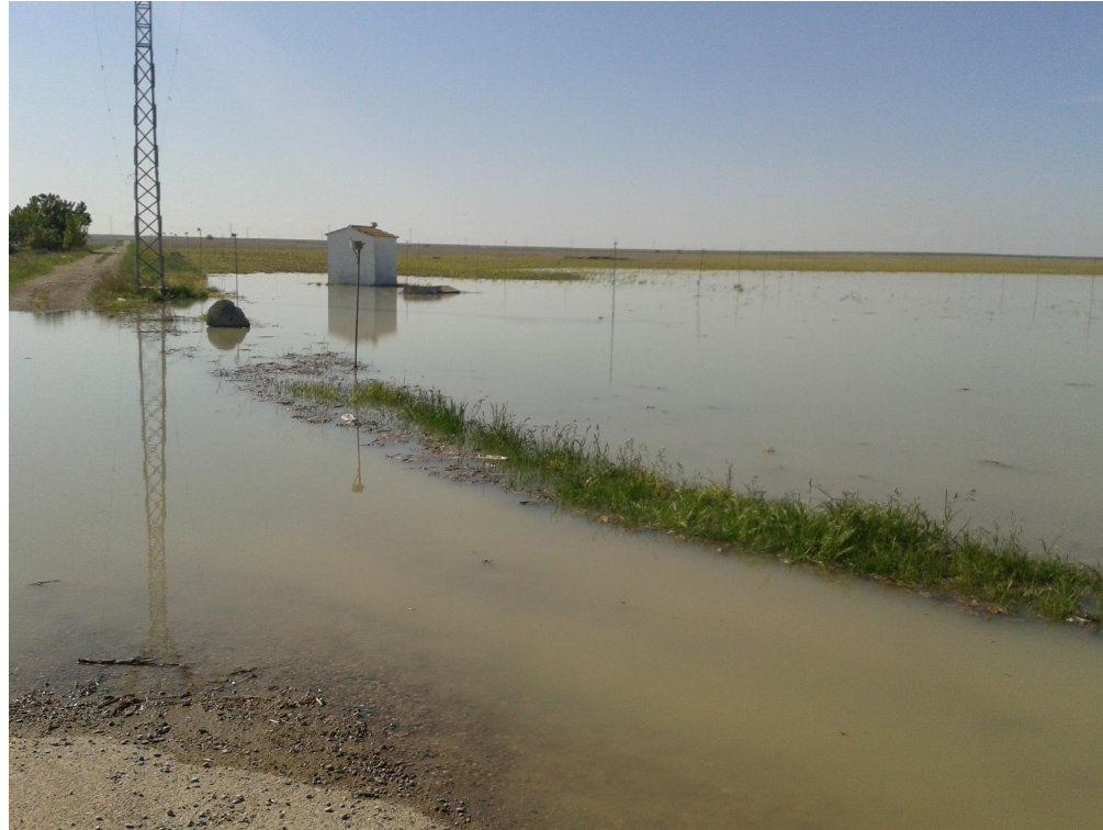
Figura 1. Ejemplo de rotura en ramales de fibrocemento
