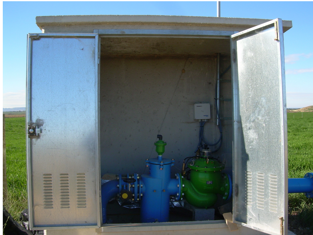
Figura 2: Hidrante único tipo
