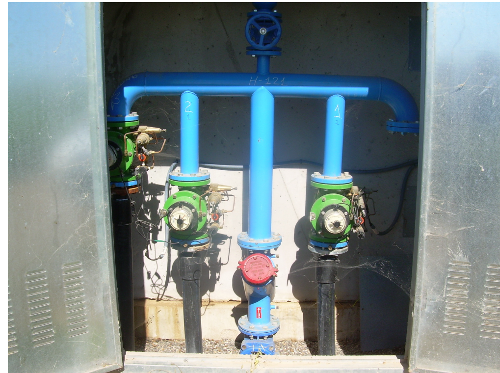
Figura 3: Hidrante agrupado tipo
