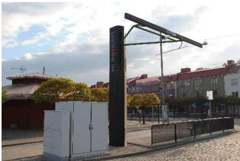
Figura 1.11 – Estación de Carga Rápida para un PHEV Bus
