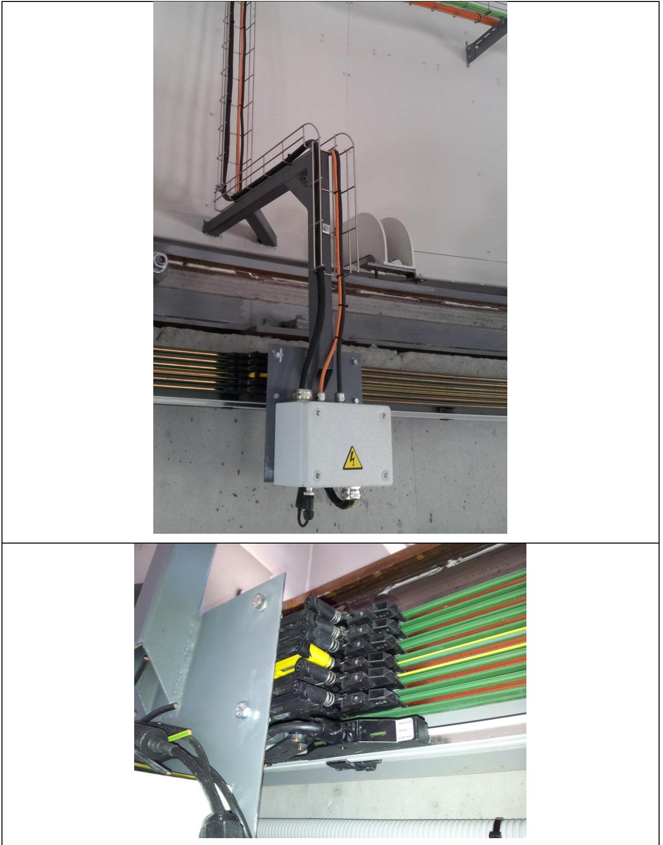
Fig. 3.7.2 – Sistema de carriles electrificados
