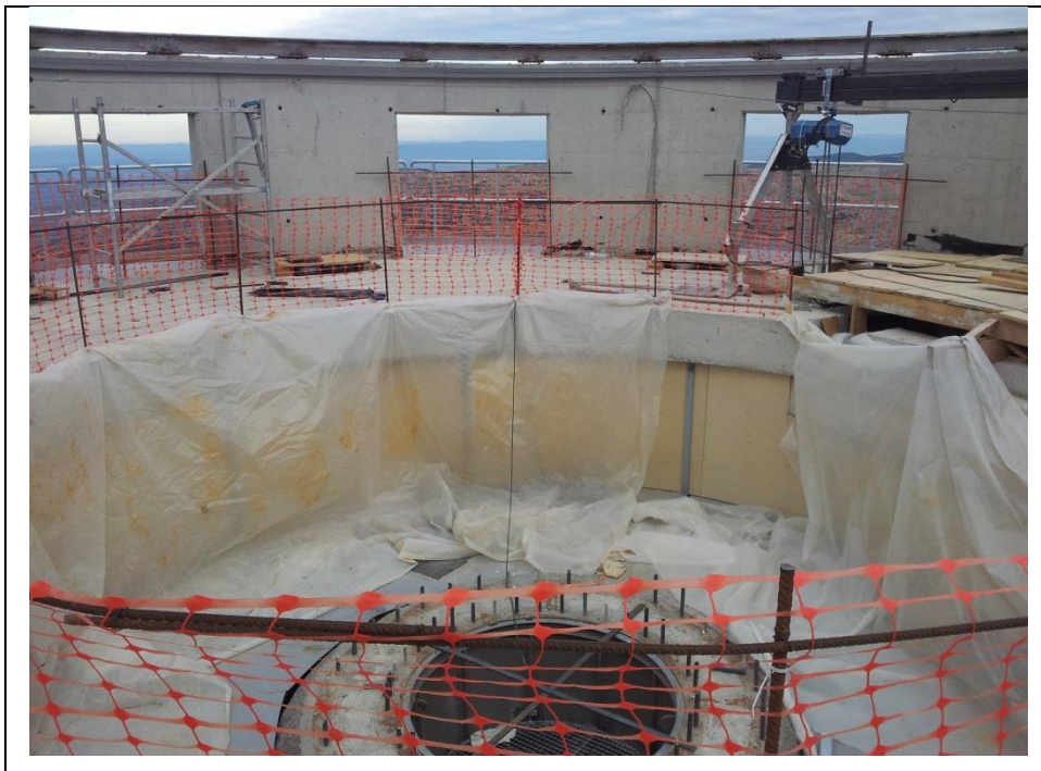
Fig. 2.1.1 – Vista de las ventanas previo a la instalación
