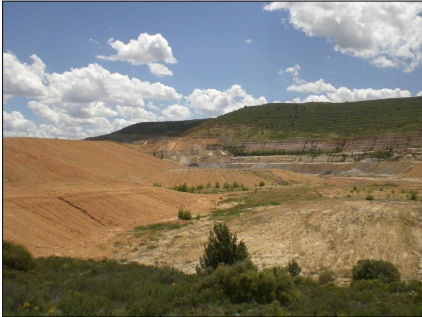
Figura nº39: Cantera Euroarce. Remodelado topográfico y extensión de tierra vegetal. FUENTE: Elaboración propia.
