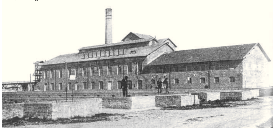
Izq.: Estado de la fábrica antes de la intervención (1) Arriba: Imagen fábrica original de 1899 (2) Abajo: Imagen edificio tras la intervención, 2001 (1)
