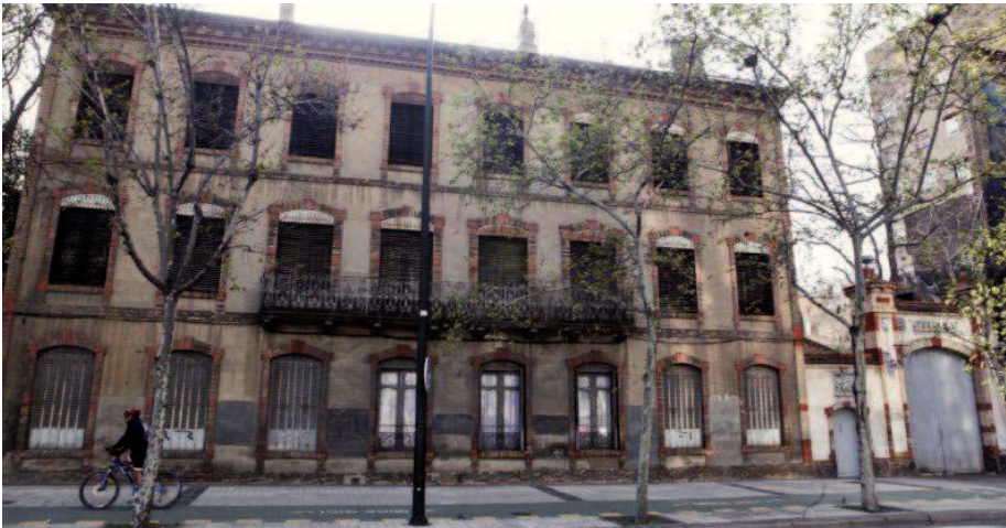
Arriba: Imagen actual de la fachada principal (3) Centro: Imagen actual de la puerta de acceso a la fundición (3) Abajo: Imagen actual de la nave de maquinaria (2)
