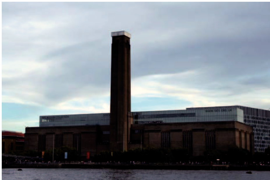
Arriba: Vista exterior del edificio tras la intervención Abajo: Vista interior, sala de turbinas Dcha.: Estructura de la cubierta y grúa puente conservada
