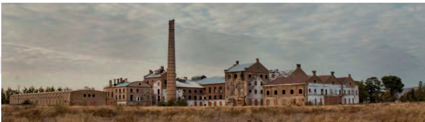
Abajo: Vista general del conjunto, estado actual (2)
