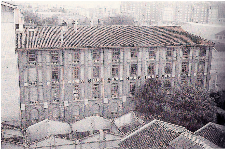
Arriba: Vista exterior de la fábrica antes de su derribo en 1998 (3) Centro: Vista exterior de los almacenes antes de su derribo en 1998 (3) Abajo: Vista interior de la fábrica de harinas (4)
