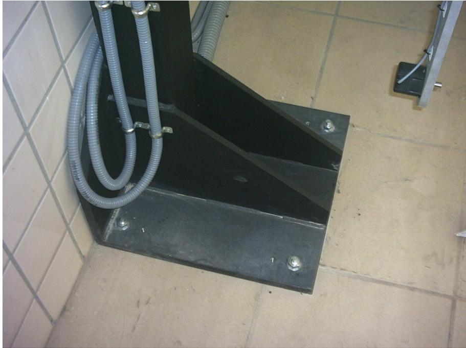
Figura A.3: Detalle de la sujeción al suelo
