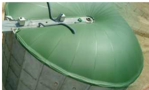
Figura 23 Cubierta Cámara de digestión
