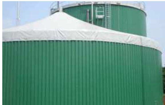
Figura 16 Exterior del depósito de digestión
