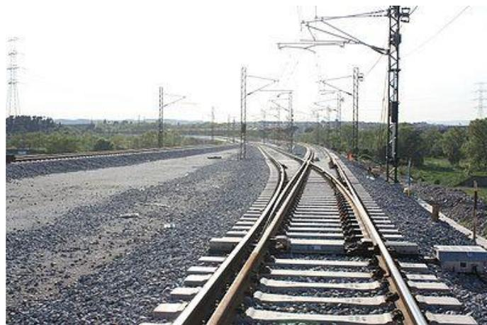
Figura 4. Desvío del ancho ibérico en vía de tres carriles. Nudo de Mollet. Fuente: Ferropedia.
