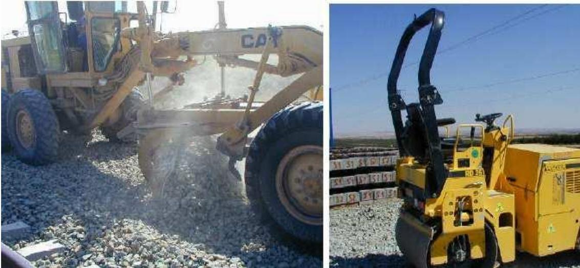
Figura 23. Acondicionamiento del lecho de balasto. Fuente: Melendo.
