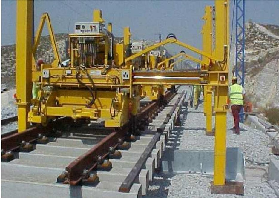
Figura 36. Operaciones de ripado (desplazamiento transversal). Fuente: Melendo.
