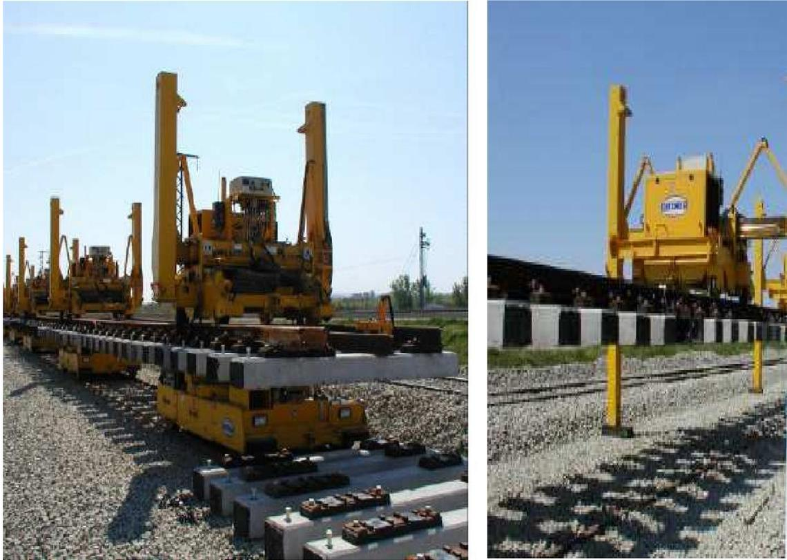
Figura 34. Llegada a ubicación definitiva y retirada de equipos LEM. Fuente: Melendo.
