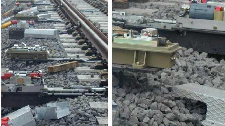
Figura 44. Tareas de montaje de motores y comprobadores. Fuente: Melendo.
