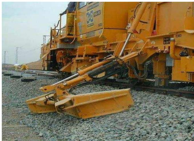
Figura 41. Trabajos de perfilado sobre la vía. Fuente: Melendo.
