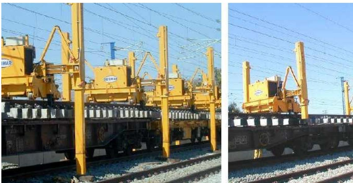
Figura 31. Carga en plataforma y traslado a ubicación en traza. Fuente: Melendo.
