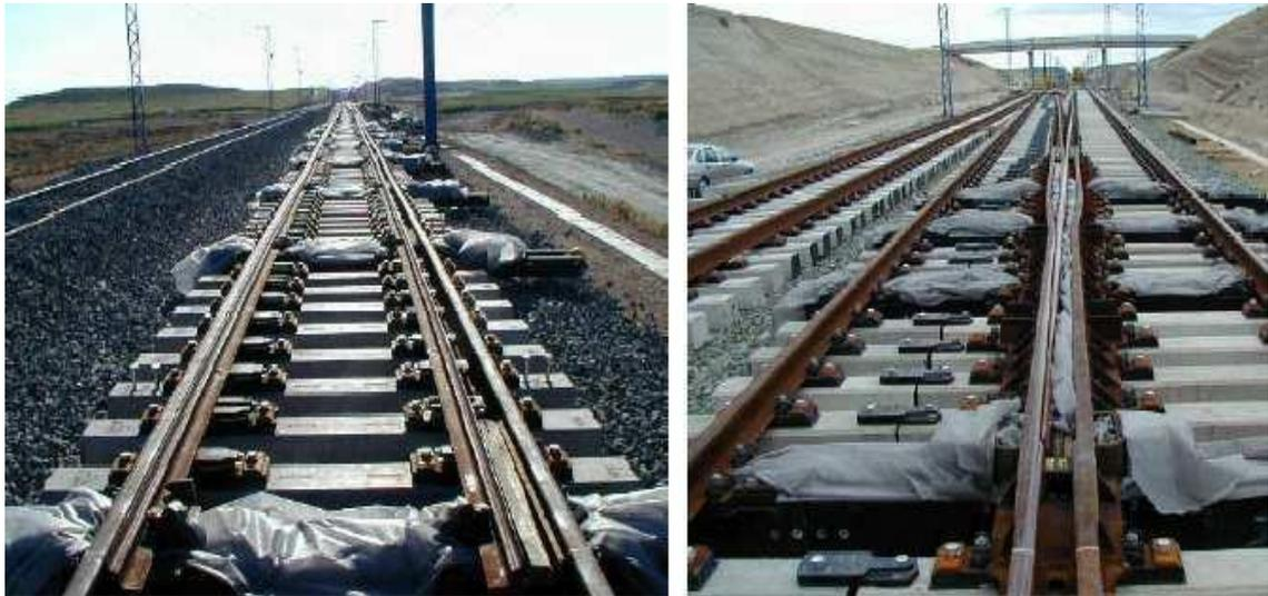
Figura 38. Operaciones previas al riego de balasto. Fuente: Melendo.
