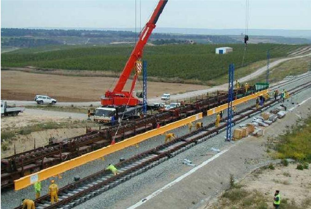
Figura 25. Tendido de la placa metálica. Fuente: Melendo.
