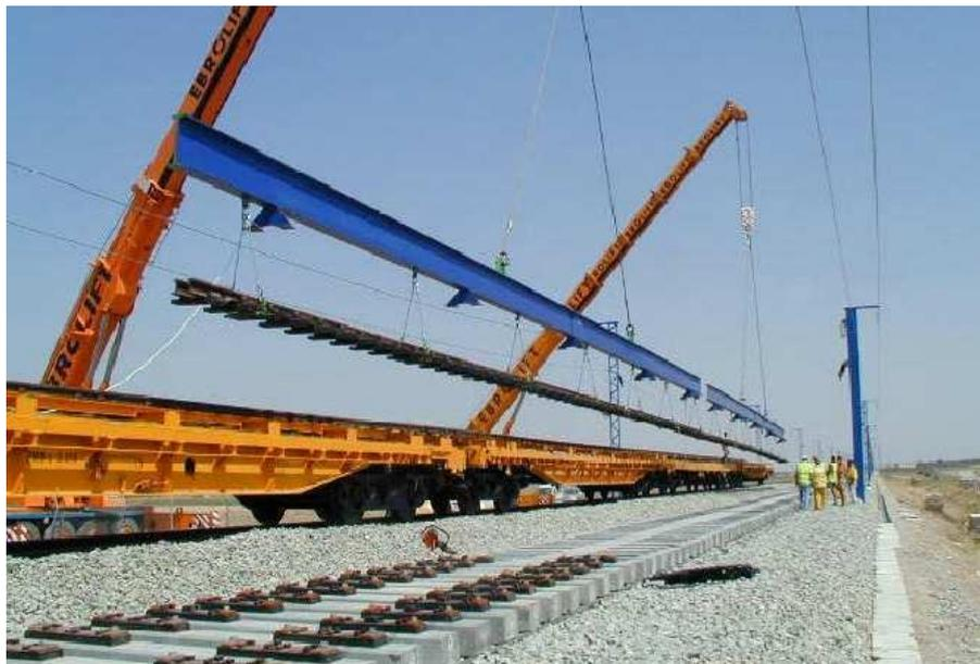
Figura 26. Descarga de los semicambios. Fuente: Melendo.
