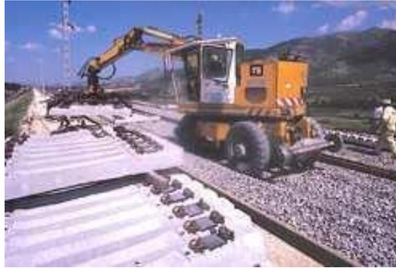
Figura 11. Montaje de traviesas. Fuente: Melendo.
