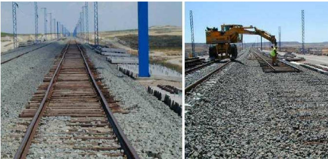
Figura 22. Acopio de traviesas en traza y retirada de la vía auxiliar. Fuente: Melendo.
