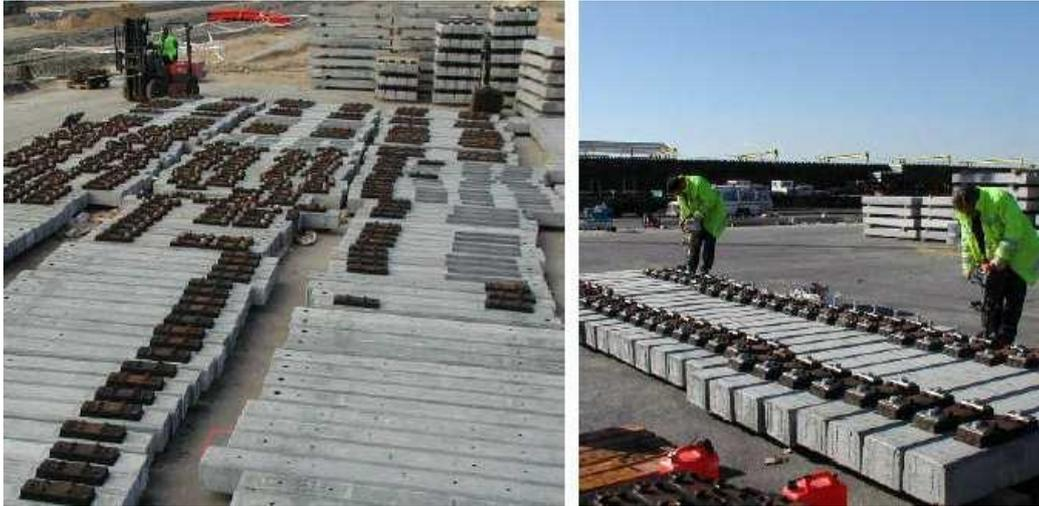
Figura 19. Acopio de traviesas en base y montaje de placas de asiento. Fuente: Melendo.
