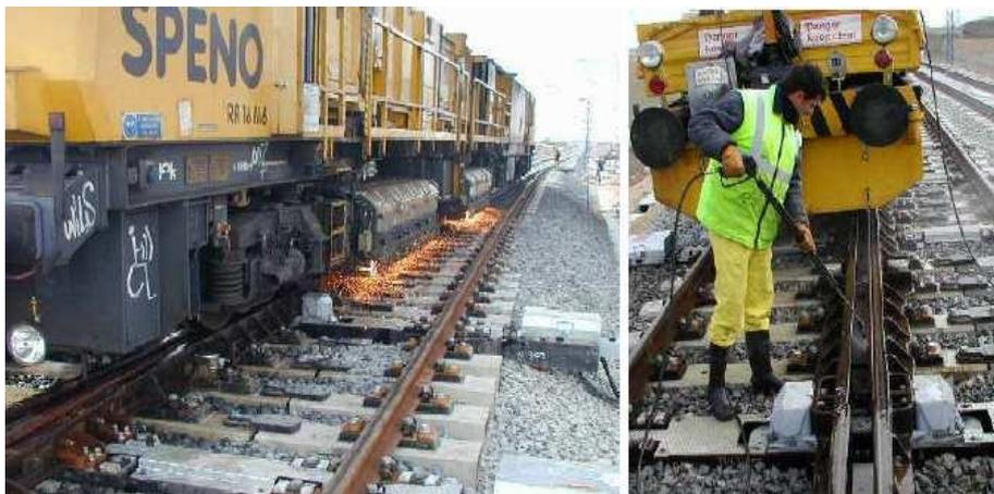
Figura 45. Trabajos de amolado y limpieza sobre elementos de la vía. Fuente: Melendo.
