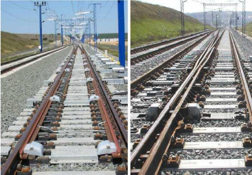
Figura 46. Desvío totalmente instalado. Fuente: Melendo.
