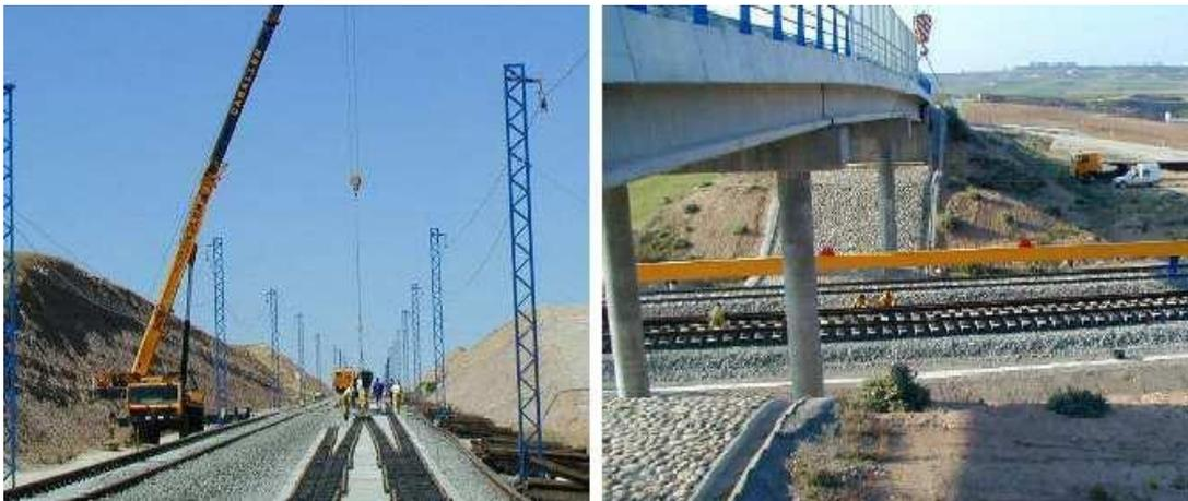
Figura 28. Descarga de la placa metálica. Fuente: Melendo.
