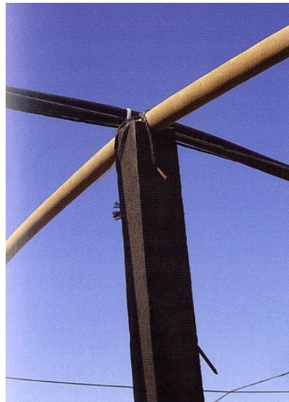
Fig. 10- Detalle del pilar interior, con una hendidura para que encaje perfectamente el arco
