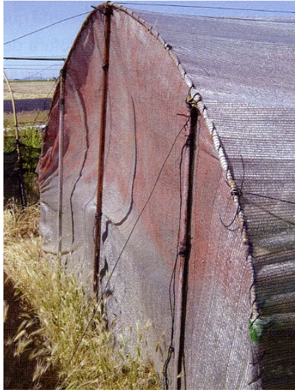
Fig. 17- Detalle de los tres pilares exteriores que soportan la tensión de los arcos
