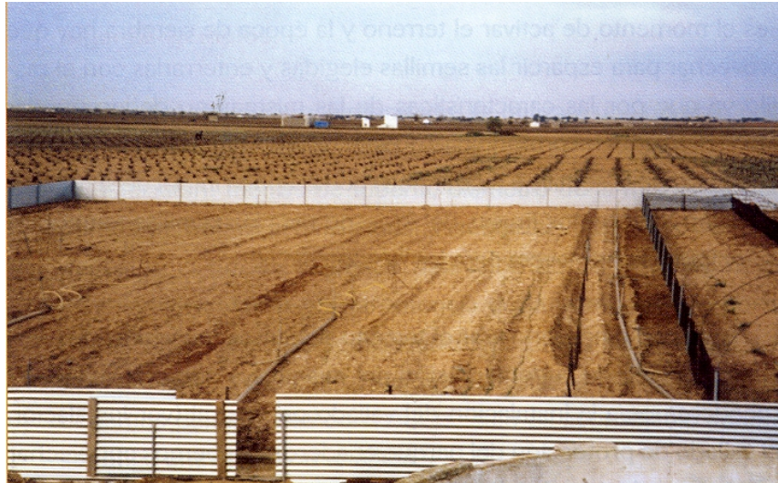
Fig. 4- Terreno preparado para la instalación de un sistema biológico extensivo. Inicialmente se ha vallado para seis recintos, vemos a la derecha uno de ellos, con los arcos de protección ya instalados.
