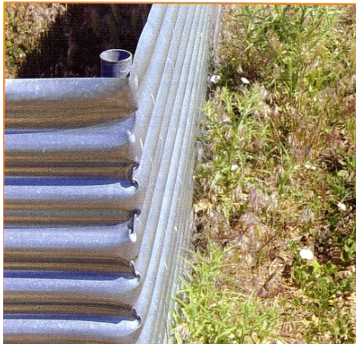
Fig. 3- Detalle de la esquina del vallado perimetral
