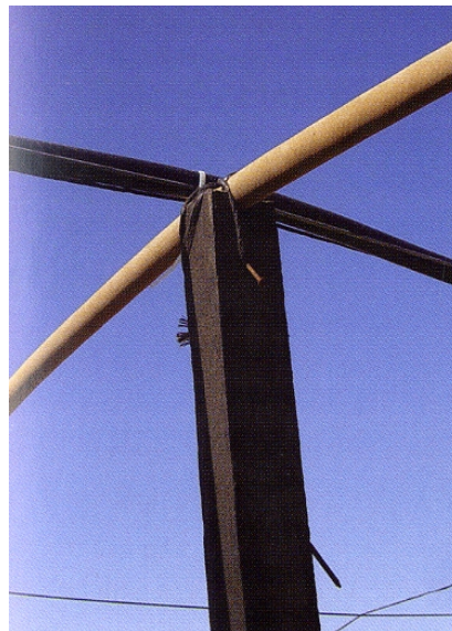
Fig. 18- Detalle del pilar interior, con una hendidura para que encaje perfectamente el arco
