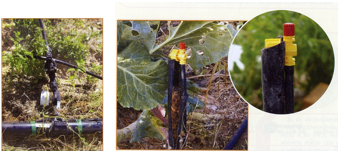
Fig. 17- Detalle de una electroválvula (dcha.), detalle de un micro-aspersor regulable en intensidad
