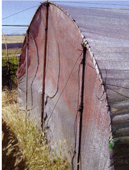
Fig. 9- Detalle de los tres pilares exteriores que soportan la tensión de los arcos
