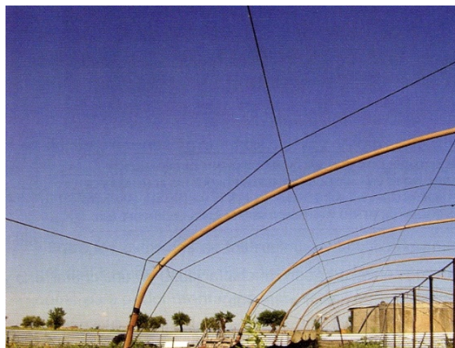
Fig. 21- Detalle de los arcos y los tensores alineado
