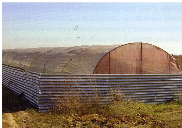
Fig. 12- Recinto recubierto con malla transparente de protección térmica
