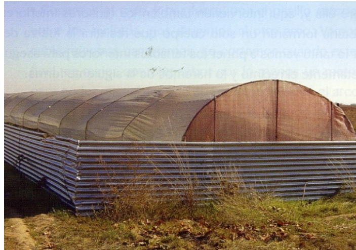
Fig. 20- Recinto recubierto con malla transparente de protección térmica
