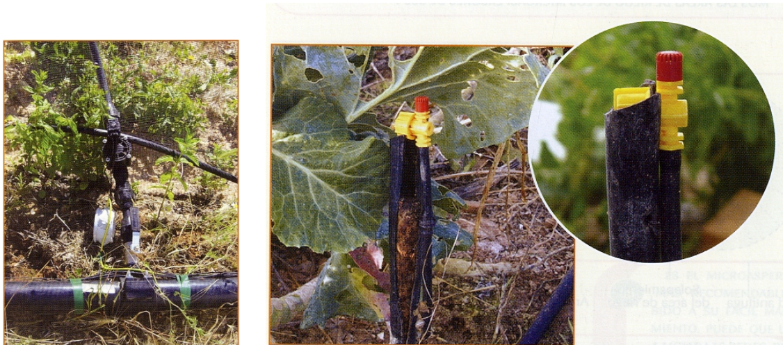
Fig. 6- Detalle de una electroválvula (dcha.), detalle de un micro-aspersor regulable en intensidad
