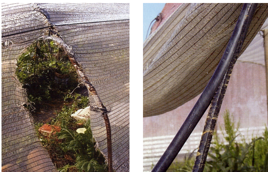
Fig. 16- Detalle de la rotura de la malla térmica por el efecto lija provocado por la oxidación del hierro corrugado, (dcha.). Protección del hierro corrugado con una tubería de plástico (izda.)
