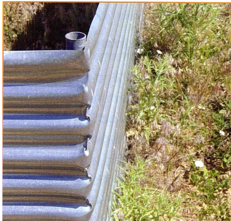
Fig. 11- Detalle de la esquina del vallado perimetral
