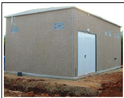
Figura 3.34. Caseta prefabricada de hormigón. Instalación aislada (I).
