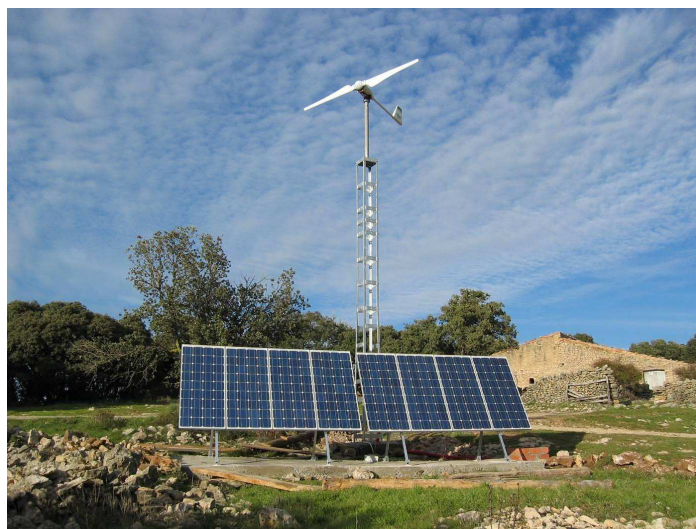
Figura 2.2. Instalación aislada. Estación de bombeo.
