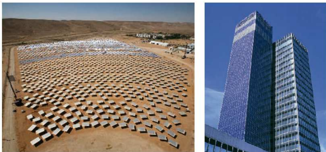
Figura 2.4. Instalaciones conectadas a red. Huerto solar y edificio fotovoltaico.
