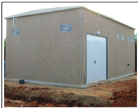
Figura 3.50. Caseta prefabricada de hormigón. Instalación aislada (II).
