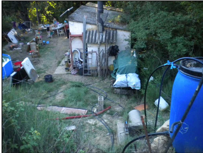
Figura 2.47. Depósitos a los que bombea el agua para disponer de ella para el merendero posteriormente [Fuente: Propia]
