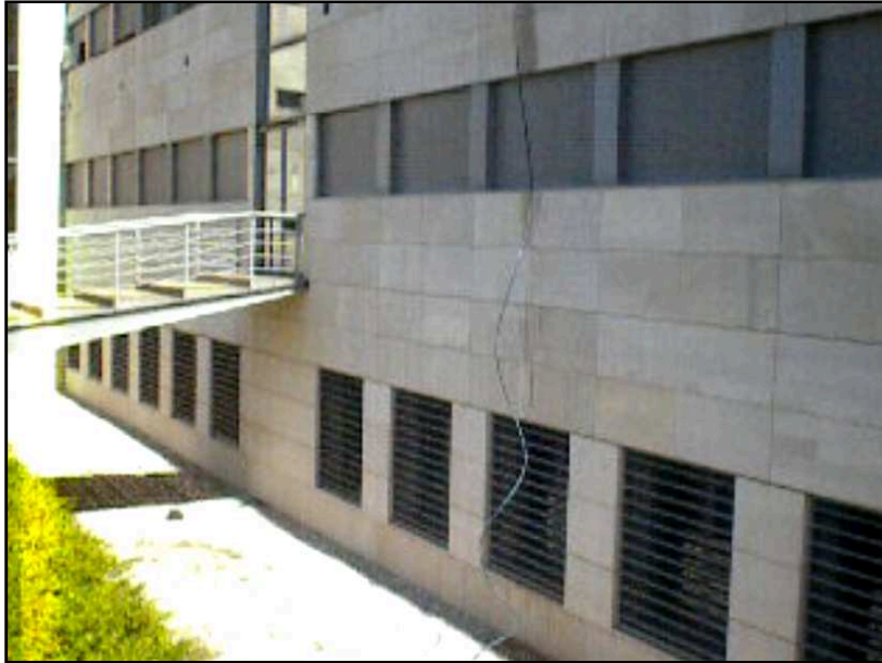
Figura 3.12. Tubería de descarga [Fuente: Propia]
