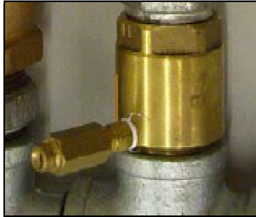
Figura 3.7. Válvula de purga de aire acoplada en una válvula no retorno [Fuente: Acitorés Martínez (2012)]
