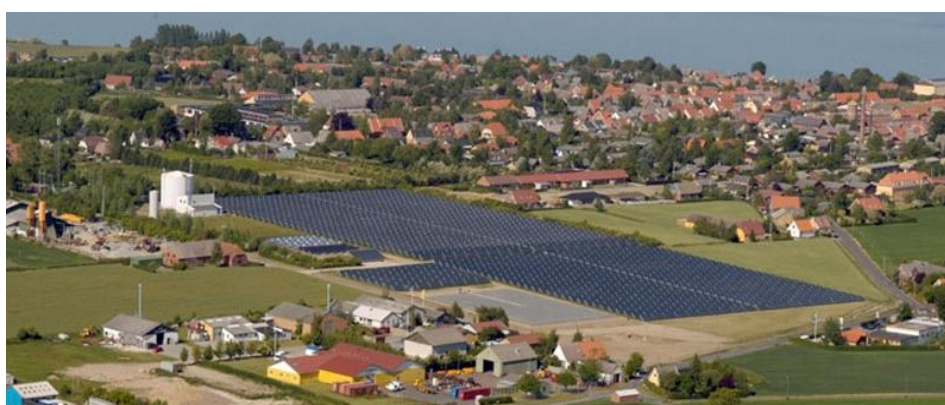
Figura A.8: Planta solar térmica de Marstal [8].
