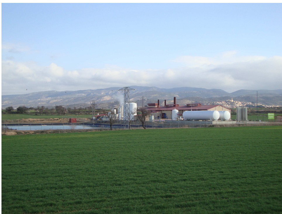
Figura 8. Vista de la planta ENERGYWORKS FONZ, S.L., con el municipio de Fonz al fondo
