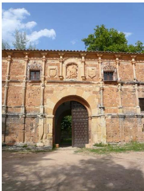
Figura 83. (Proyecto JUN 2009, DOC. FOT.) Puerta de acceso y cuerpo central de la fachada. Contrasta el estado de cubierta, cornisa de alero y friso superior, restaurados con la cubierta, y los tramos inferiores. El agua procedente de cubiertas hacía crecer la hierba sobre la acera.
