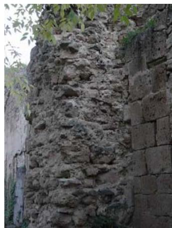
Figura 61. (Proyecto JUL 2004, foto 10). Estado del contrafuerte del tramo de los pies, reducido a un tercio de su sección, su núcleo interior de mampostería gruesa y mortero de cal.
