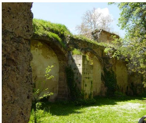
Figura 60. (Proyecto JUL 2004, foto 9). En el exterior, se distingue un contrafuerte parcialmente reconstruido, mientras que en los tramos siguientes se hallan reducidos.
