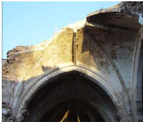
Figura 59. (Proyecto JUL 2004, foto 4). Lateral derecho del crucero. Bóveda hundida en su mitad, permaneciendo el resto en equilibrio inestable. Años anteriores se atirantaron los nervios diagonales con una estructura de perfiles laminados, como solución provisional.
