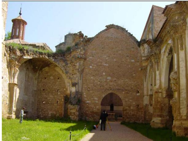
Figura 62. (Proyecto JUL 2004, foto 6). Vista general de la iglesia hacia la cabecera: el muro frontal separaba la zona de monjes de la de conversos. Se observa la inexistencia de la nave lateral izquierda.
