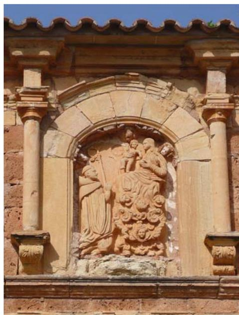
Figura 84. (Proyecto JUN 2009, DOC. FOT.) Bajorrelieve en el centro de la fachada, posiblemente copia del original. La cornisa sobre el arco y el fondo estaban muy degradados.
