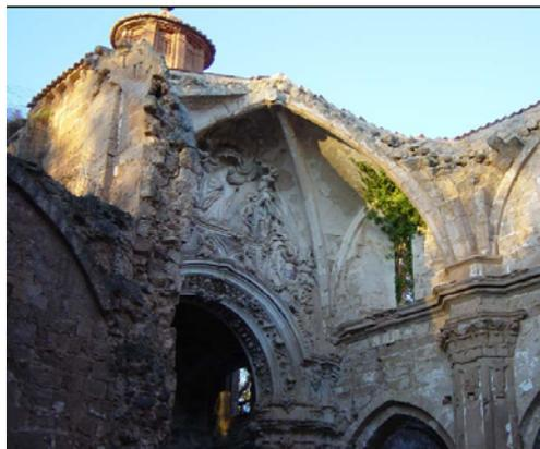
Figura 58. (Proyecto JUL 2004, foto 3). Lateral izquierdo del crucero y capilla de San Bernardo. Bóveda hundida; restos de plementería en equilibrio inestable y fractura en el muro del lado izquierdo. En el muro seccionado se aprecia el sistema constructivo medieval del muro de tres hojas: dos exteriores de cantería y un relleno central de mortero de cal y casquijo.
