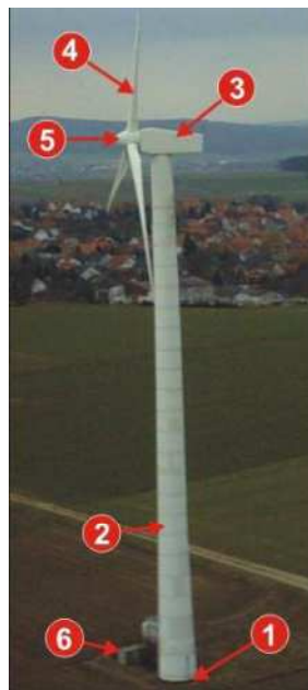
Figura 2.1 Partes principales de un molino.
