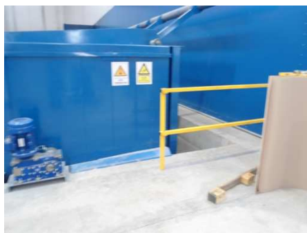
Acceso a foso horno
