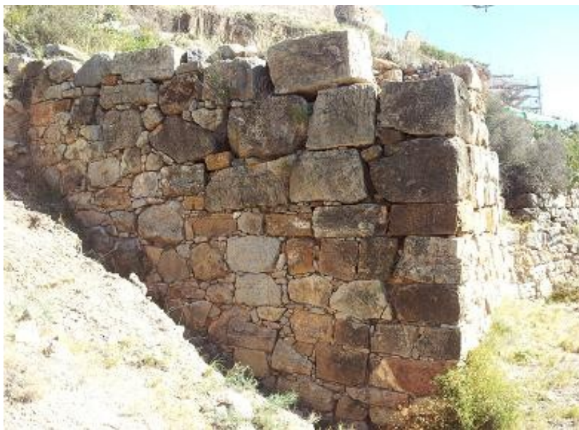
Ilustración 20. Muro íbero de aparejo poligonal de Sagunto. Fuente: http://www.tarraconensis.com/saguntum/monumentos.html
