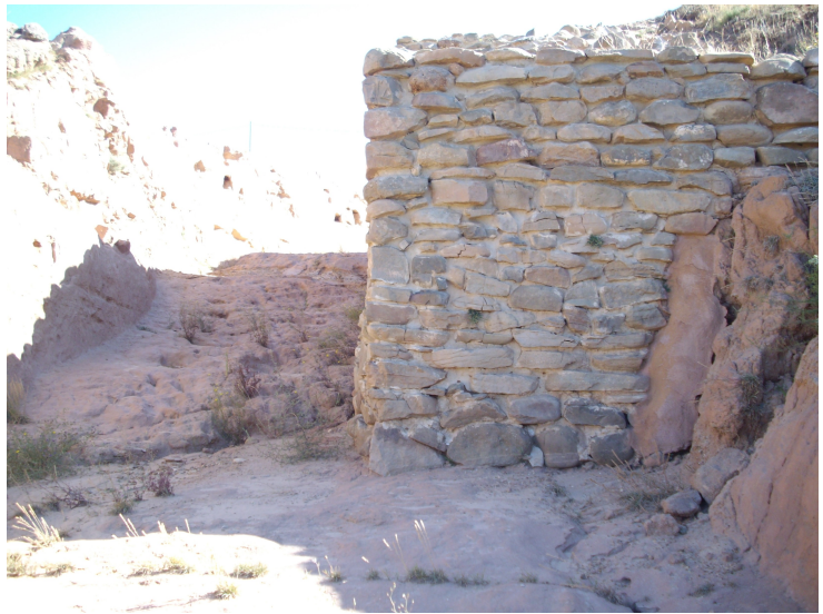
Ilustraciones 30 y 31. Izquierda: Vista del muro en sección. Se aprecia el paramento interno cuidadosamente colocado en sucesivas hiladas. Derecha, Se aprecia la anchura del foso, y el propio arranque en este lado del perímetro defensivo de la base de la muralla en el mismo foso. Fuente: FdA
