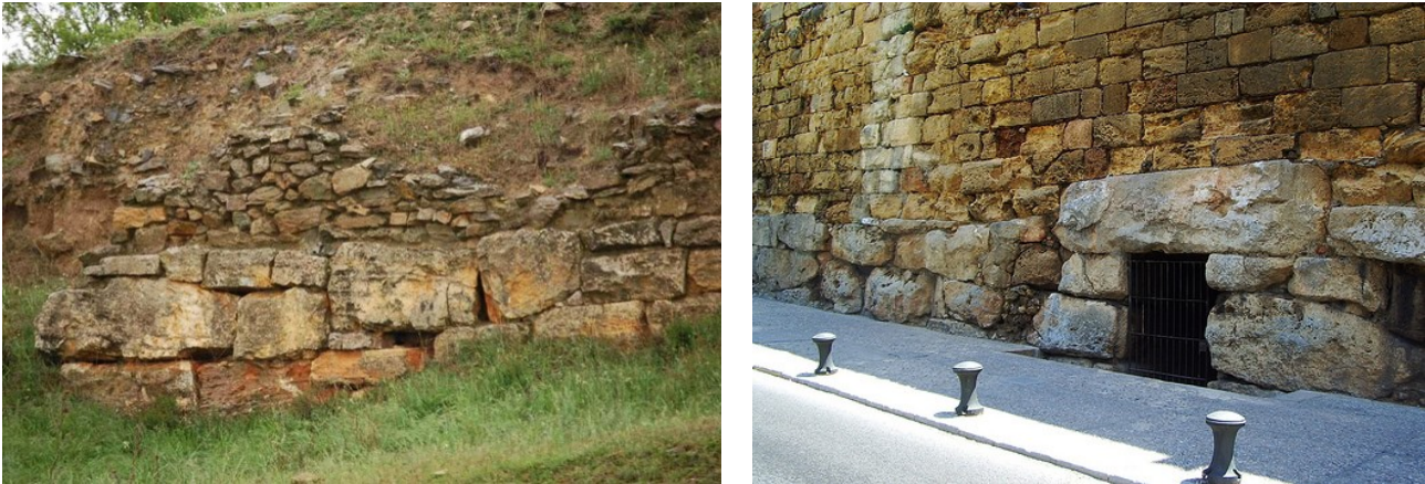
Ilustración 18 y 19. Muros de construcción ciclópea. Fuentes: http://www.flickr.com/photos/vertice1/6949456185/ y http://www.celtiberia.net/articulo.asp?id=2638
