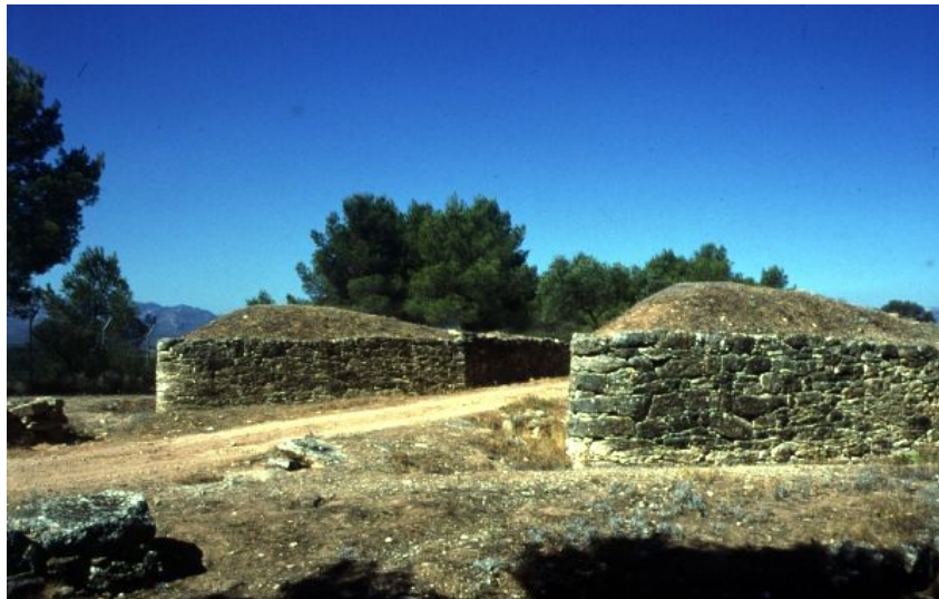
Ilustración 23. Base de las torres que flanquean la entrada del yacimiento íbero de Castellet de Banyoles. Fuente: http://www.arqueotur.org/yacimientos/castellet-de-banyoles-de-tivissa.html
