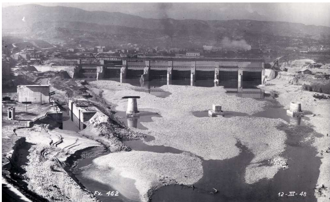
Fig. 50. Embalse de Flix que substituyó al antiguo azud. A la izquierda antiguo canal de navegación con su esclusa que servía para salvar el desnivel del azud. En el curso, los pilares del puente que había proyectado el gobierno de la República y que quedó sin terminar (Fuente: Archivo municipal de Flix).
