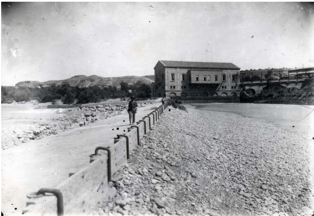
Fig. 49. Detalle del azud de Flix en época de estiaje. Al fondo la Casa de Turbinas (Fuente: Archivo municipal de Flix).
