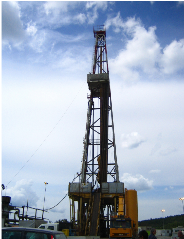
Sondeo geotérmico en Larderello, Italia (fotografía D. Lamarca).
